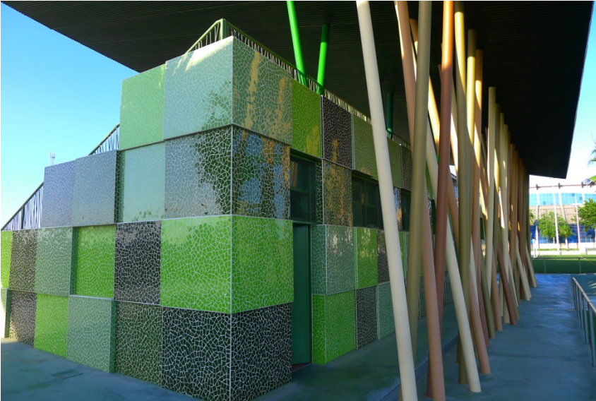
Instalaciones de fútbol de la Ciudad Deportiva de Torrevieja
