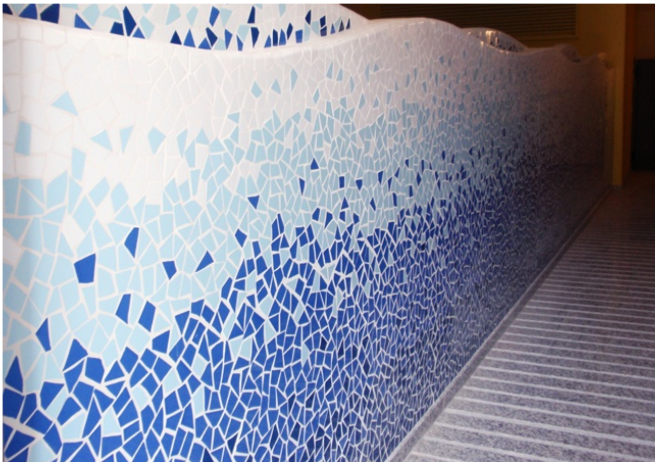
Entrada de edificio
